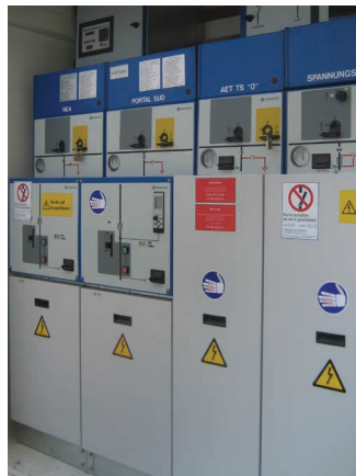
Tunnel Gotthard (Suisse)
